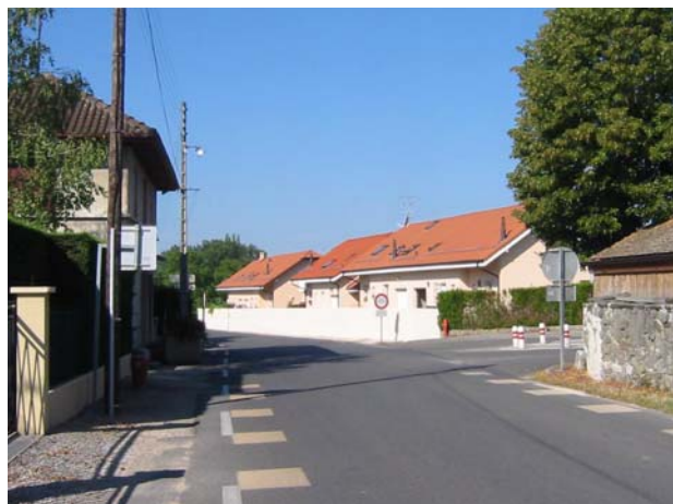
Le lotissement de villas à Cara: vue depuis la route de Juvigny sur France et vue depuis la campagne suisse
