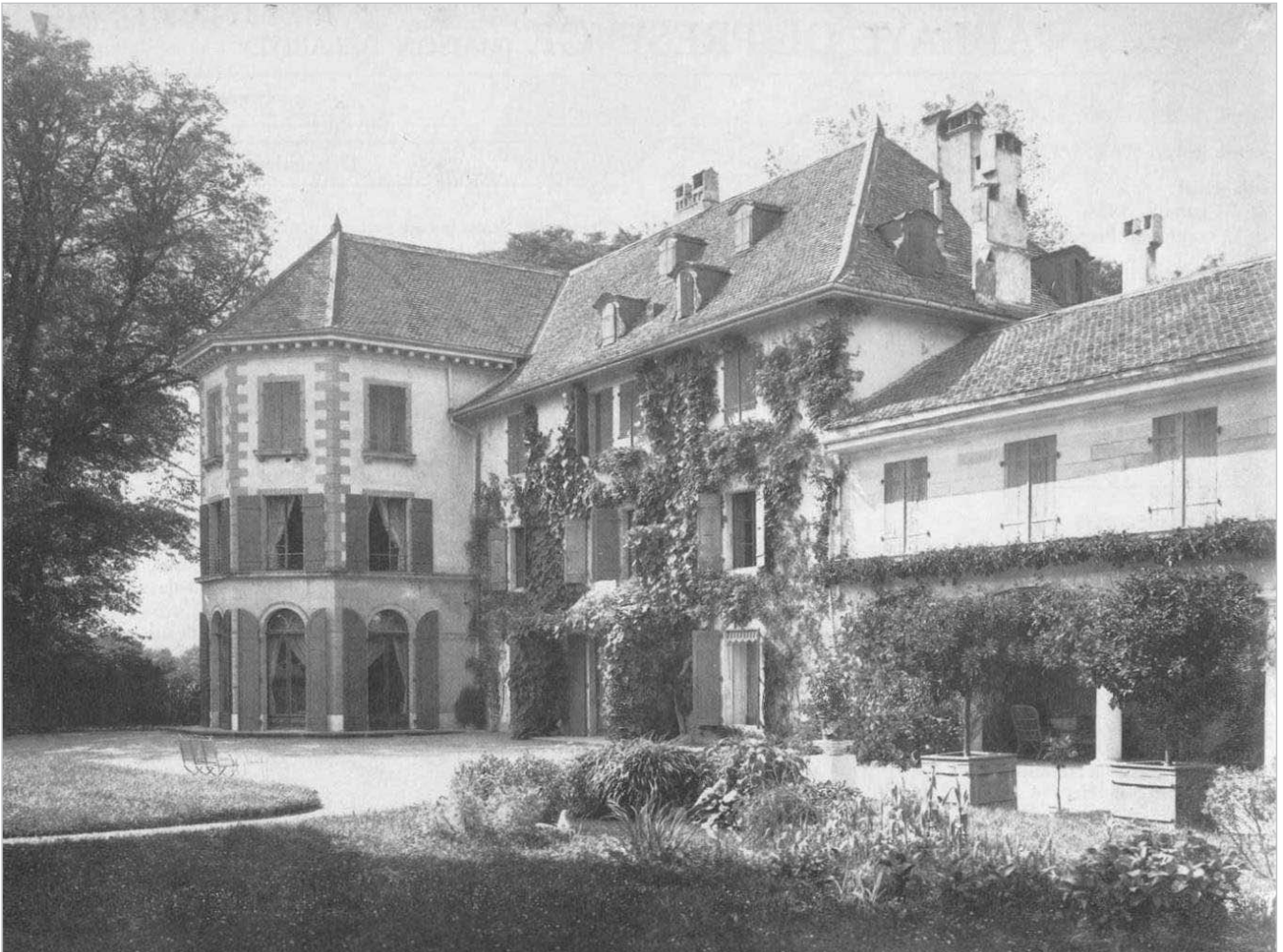
Maison De la Rive à l'Abbaye: photographie ancienne des bâtiments vus du sud (source: EL-WAKIL). Le Recensement architectural attribue à cet ensemble une valeur 2 "remarquable" (Ra PSG 101 à 103)
